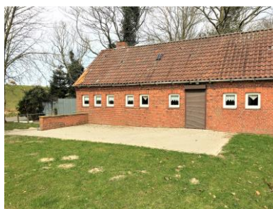
Neue Terrasse am Gemeindehaus-Nord
