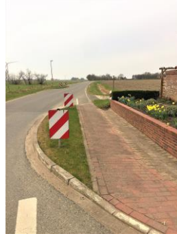
Radweg von Marnerdeich-Nordseestraße bis zum Kreisel Kirchenstraße
