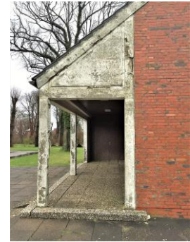
Sanierung der Leichenhalle
